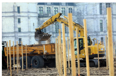
Le chantier des jardins à la française avance bien et Chambord a reçu un mécénat exceptionnel de 3,5 millions d'euros.
