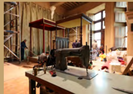
La chambre du roi en travaux
